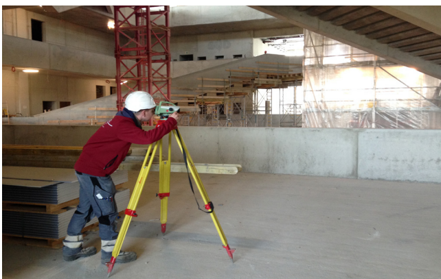
Setzungsüberwachung des Baukörpers mittels Nivellement
