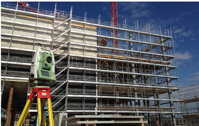
Präzise Vermessungsarbeiten während des Rohbaus
