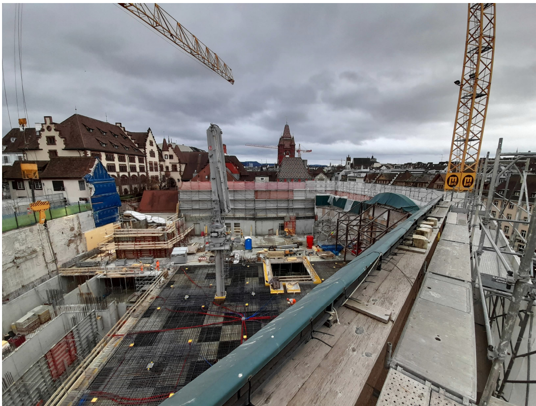
Abbildungen: Situation der Baustelle mit dem Rohbau, welcher innerhalb der bestehenden, aufwändig gesicherten und denkmalgeschützten Fassade neu errichtet wurde.
