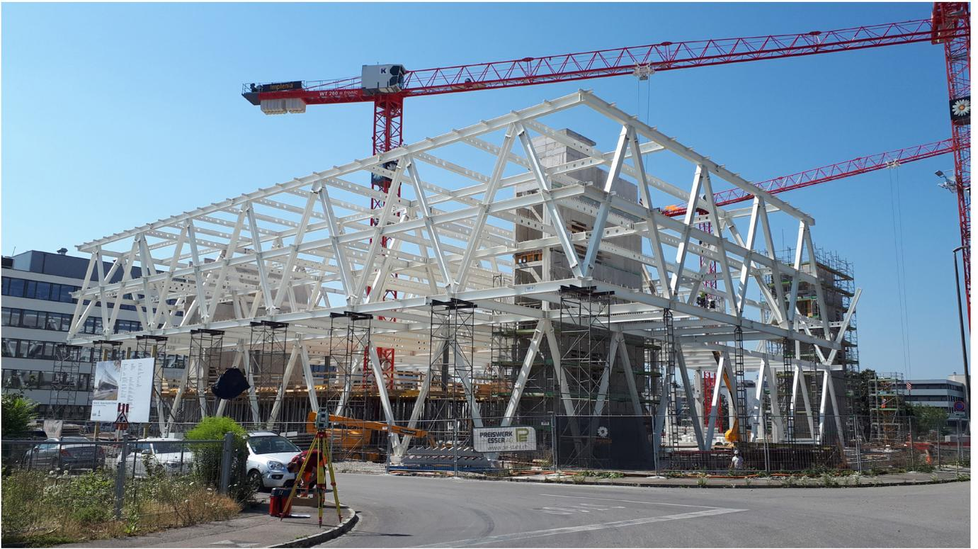
Die **3D-Vermessung** und **Überwachung** des imposanten **Stahlbau-Skeletts** stellte sich als gleichermassen interessante wie anspruchsvolle Aufgabe dar.
