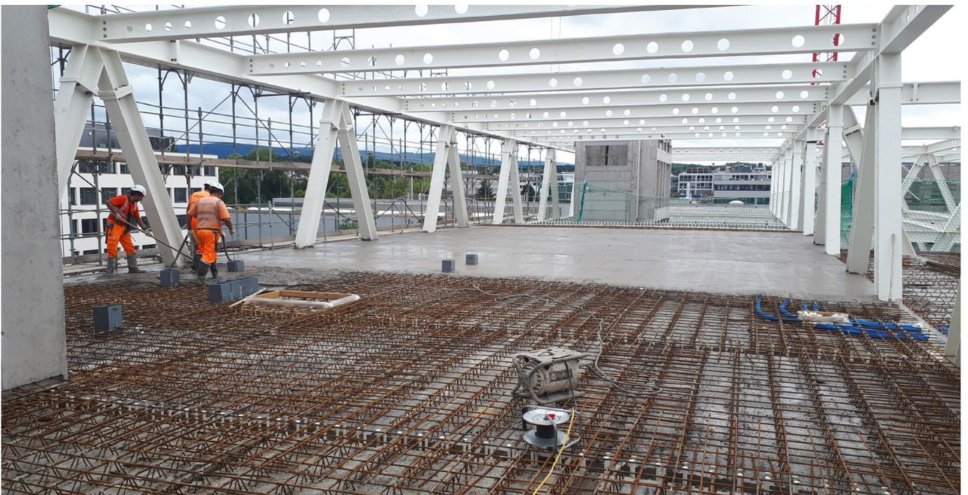
Die **Geschossdecken** wurden als Teil-Fertigelemente in das **Stahlbauskelett** platziert und mit Ortbeton ausgegossen. Die Rohbauelemente mussten daraufhin auf Masshaltigkeit **messtechnisch** überprüft werden.
