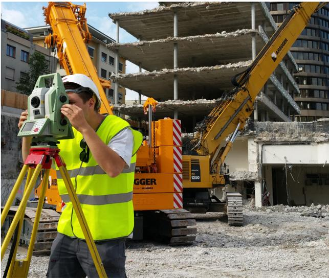
Mit dem Baustart auf dem Baufeld F begann auch die **Bauvermessung** für den Baloise-Park. Von Detailaufnahmen der bestehenden Objekte, über Absteckungen, Referenzangaben und Rohbetonkontrollen wurden viele Arbeiten durchgeführt. Der Bau des Turms folgte im Anschluss. Durch die gerüstlose Bauweise mit einem Kletterschild wird ausgebildetes Personal im Umgang mit Absturzsicherungen vorausgesetzt.
