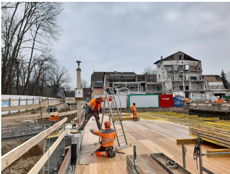
Abbildungen: GNSS-Referenzstation der Baustelle auf benachbartem Gebäude (oben), mobile Fixpunktstation mittels GNSS-Antenne und 360°-Prisma auf Stahlpfeiler (unten)
