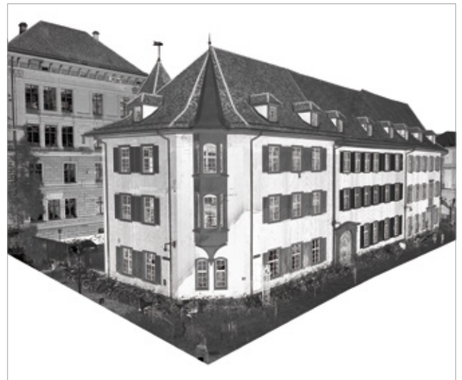
3D-Punktwolke einer Altstadt-Liegenschaft
