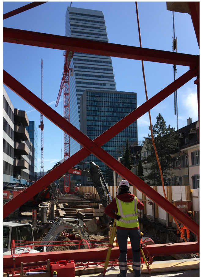
3D-Überwachungsmessung des Rampenverbau
