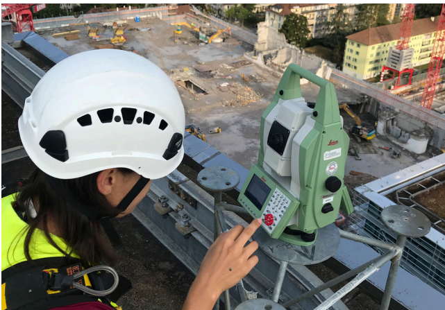
Präzise Vermessungsarbeiten hoch über dem Roche Areal Basel
