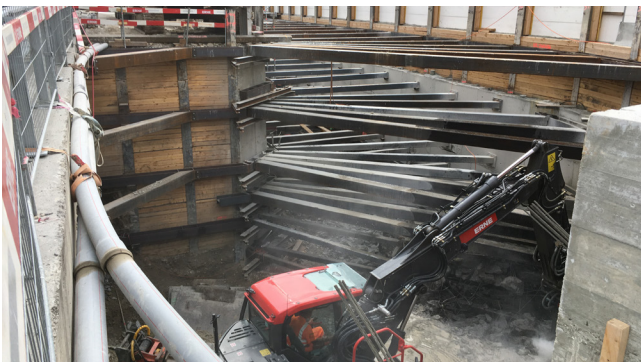
Baugrubensicherung mit Spriessung der neuen Zufahrtsrampe
