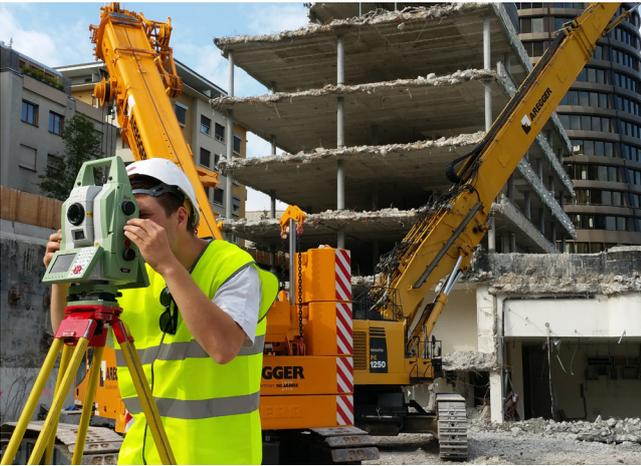
Mit dem Baustart auf dem Baufeld F begann auch die **Bauvermessung** für den Baloise-Park. Von Detailaufnahmen der bestehenden Objekte, über Absteckungen, Referenzangaben und Rohbetonkontrollen wurden viele Arbeiten durchgeführt. Der Bau des Turms folgte im Anschluss. Durch die gerüstlose Bauweise mit einem Kletterschild wird ausgebildetes Personal im Umgang mit Absturzsicherungen vorausgesetzt.
