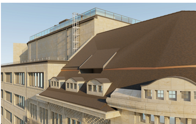
Exakte Auswertung der Dachaufbauten und der Terrassen
