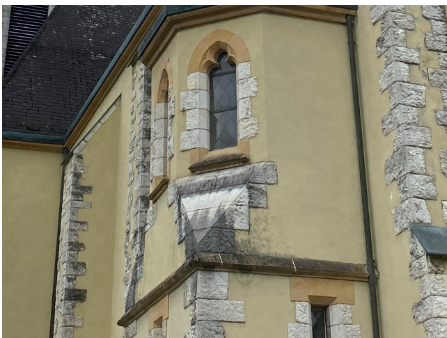
Fassadendetail: jedes sichtbare Element wurde in den Plänen dargestellt
