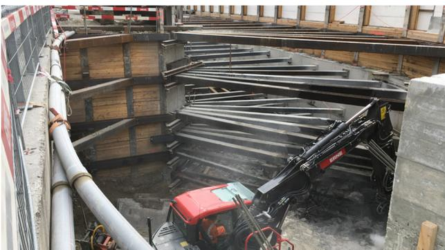
Baugrubensicherung mit Spriessung der neuen Zufahrtsrampe
