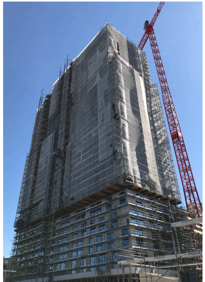
Das Gebäude hat seine Endhöhe im Sommer 2018 erreicht
