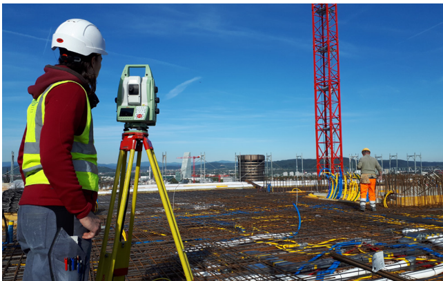
Anspruchsvolle Vermessungsarbeiten hoch über der Stadt Basel
