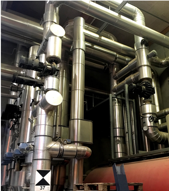
Komplexe Installation von Rohrleitungen
