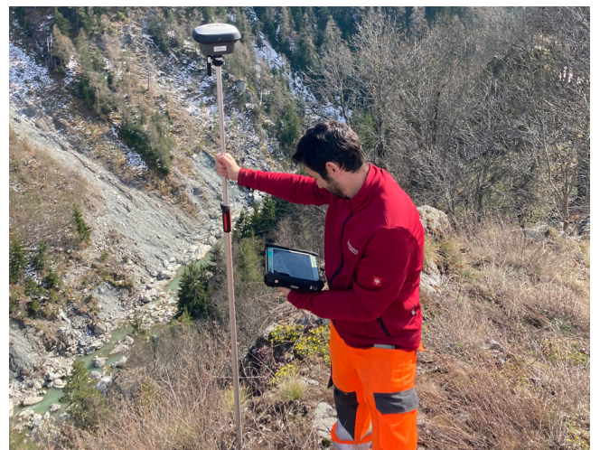
Einmessung der lokalen Festpunkte zur genauen Lagebestimmung
