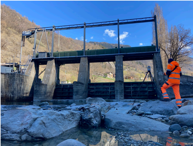
Um im Flussbett zuverlässige Punktdaten erfassen zu können, wurde vorgängig das Wehr geschlossen
