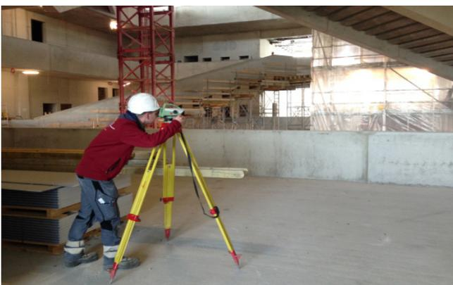
Setzungsüberwachung des Baukörpers mittels Nivellement
