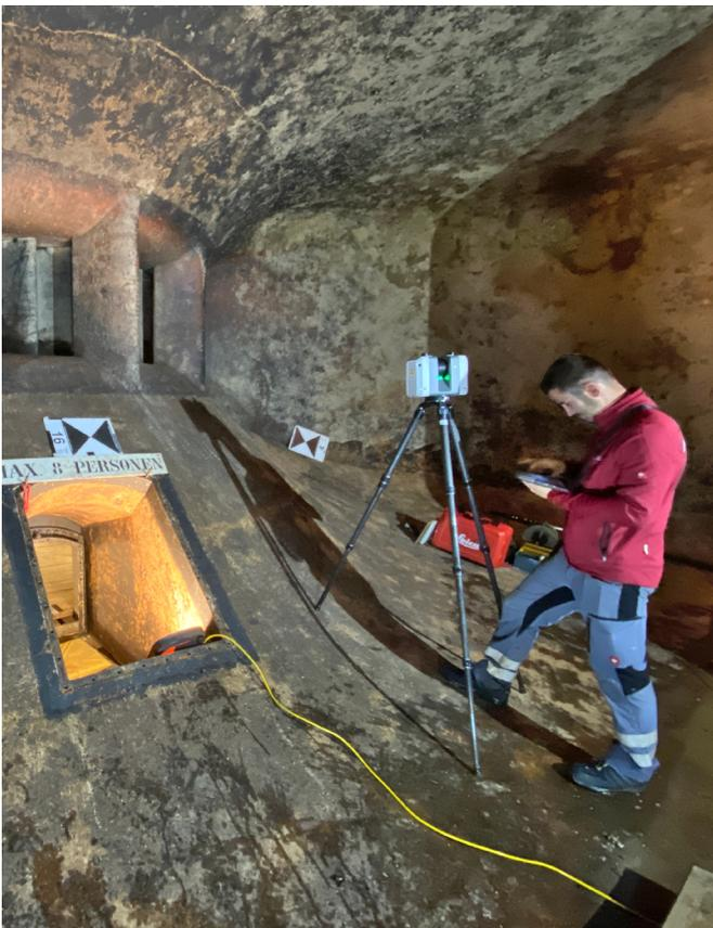
3D-Scanning im trockengelegten Turbinengehäuse
